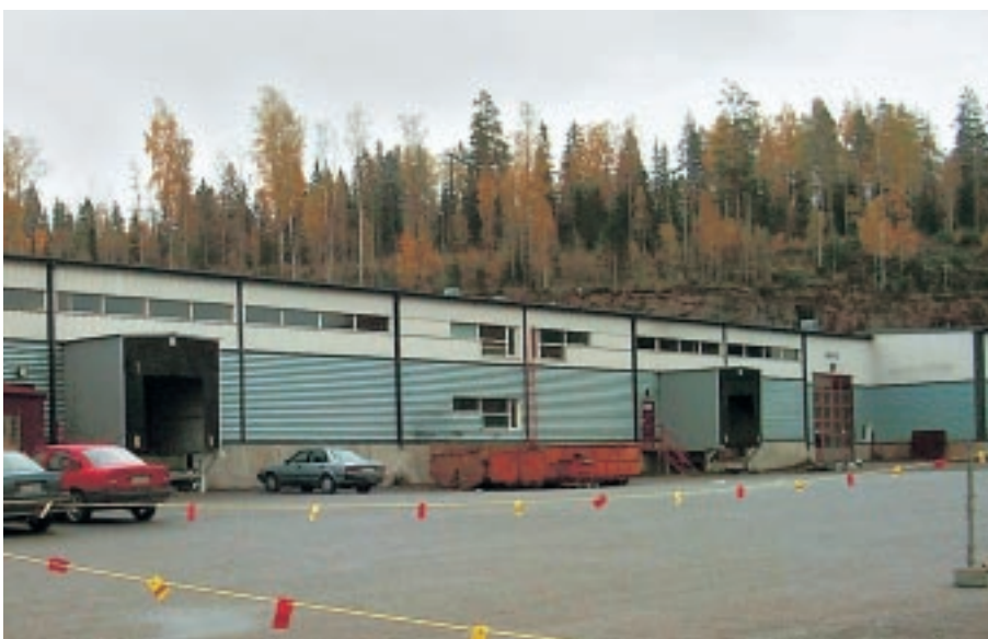
Tähän rakennukseen Seppälänkankaalle sijoittuu Aluetekniikan päätukikohta. Entisessä KAK-Kuljetuspalvelun kiinteistössä tehdään parhaillaan perusteellista kunnostusta.
