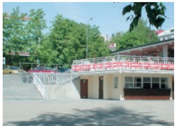
Lounaispuiston kioski ja pohjakerroksen wc-tilat ovat peruskorjattu perusteellisesti.
