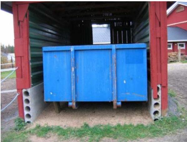
Kuva 3. Siirtolava sijoitettu katokseen ja tiiviille alustalle.
