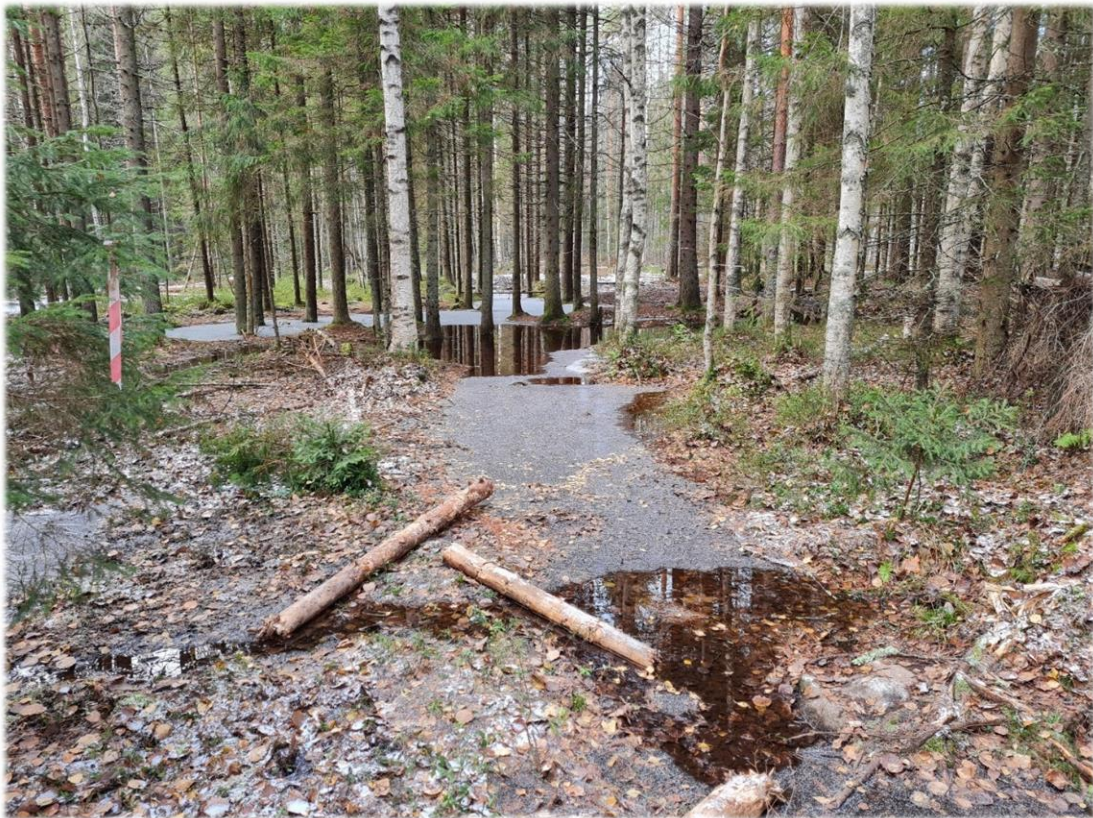
Kuva 8 Riihilammensuolla ojen patoaminen nostatti veden pintaa märän syksyn aikana (kuva: Matti Häkkilä)
