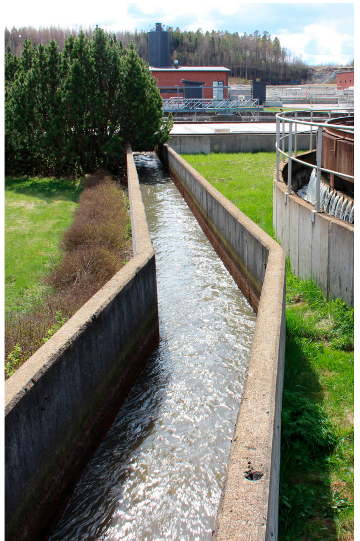
Esiselkeytettyä jätevettä virtaa kanavassa kohti aktiivilieteprosessia.
