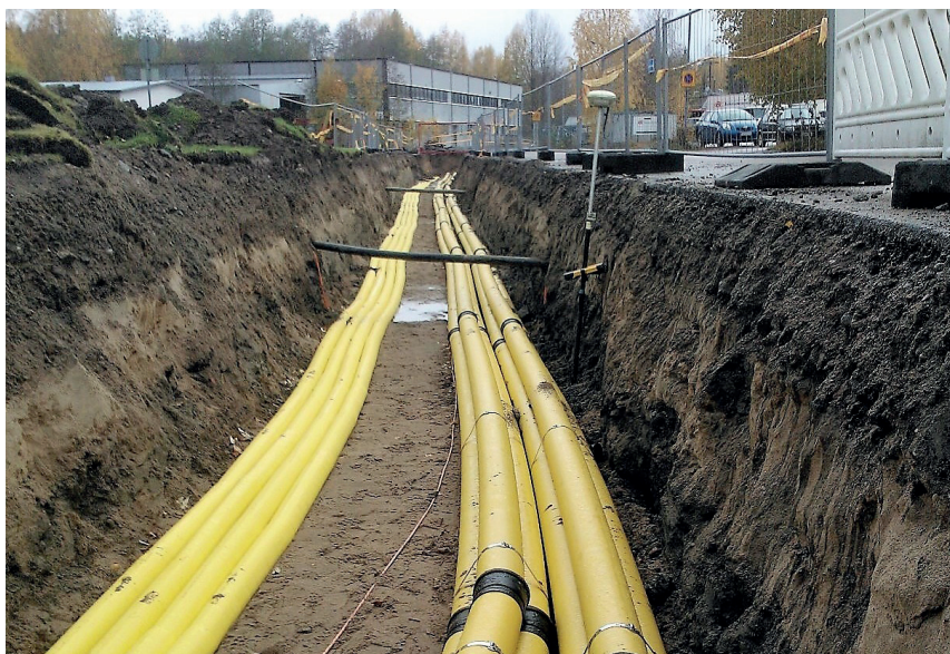
Kuvassa oikeaoppinen 20kV ja 110kV johtojen sijoitus samaan kaivantoon.
